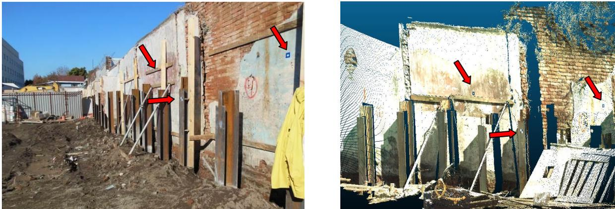
Fig.2 – a) Imagen real, se observan puntos de control en muro de albañilería y perfil de muro berlinés, b) Imagen digital obtenida con HDS.
