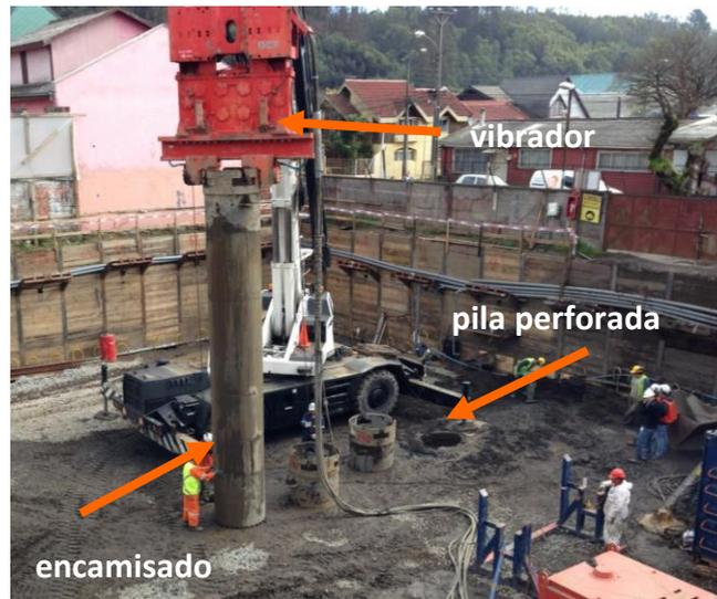
Fig. 2 - Construcción de pilas de grava vibrando el encamisado con grava en su interior
