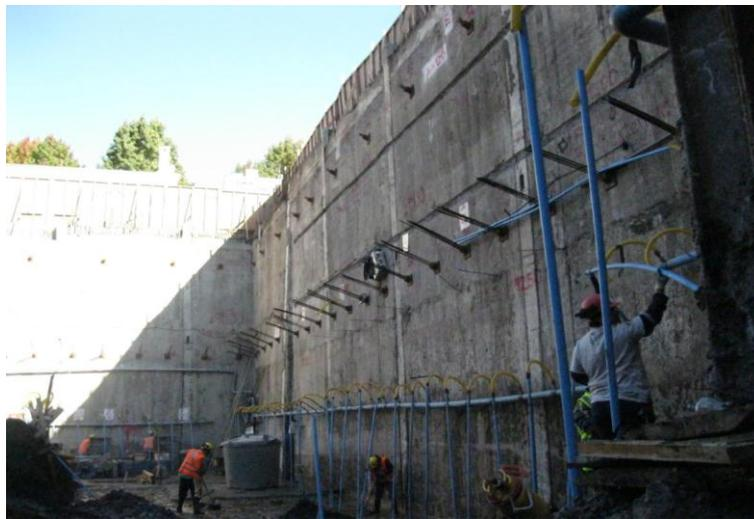
Figura 8: Líneas de anclaje del muro pantalla que contiene las casas vecinas a la excavación, mostrando instalación del sistema de agotamiento
