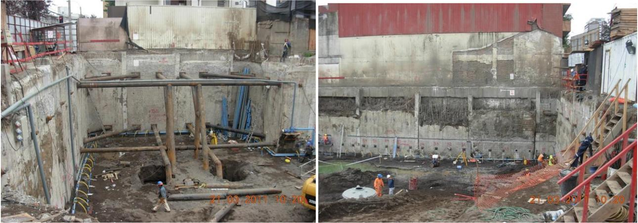
Figura 7: a) Ubicación de los de apuntalamientos utilizados en el proyecto de muro pantalla y b) línea de anclaje del muro pantalla que contiene al edificio vecino a la excavación
