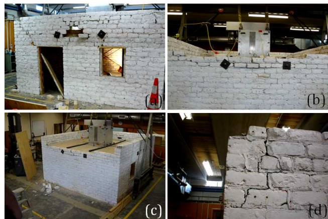
Figura 6: Daño observado al nivel DS4. (a) Muro Norte, (b) detalle muro Sur, (c) vista general muro Sur, y (d) detalle esquina Noreste.
