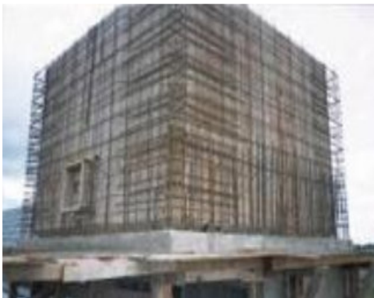
Figura 1.5 Estanque rectangular de hormigón armado (Fuente: http://www.cassina.com )
