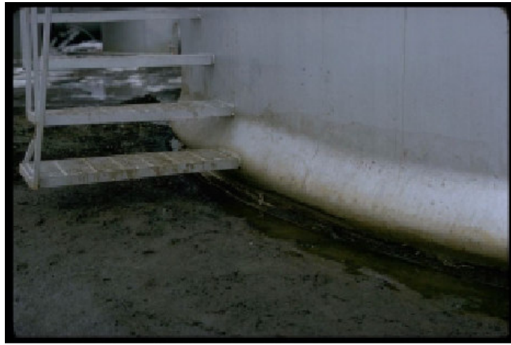
Figura 2.2 Pandeo “pata de elefante” de la pared. Alaska-1964. (Fuente: Colección Steinbrugge. EERC, U.C. Berkeley)
