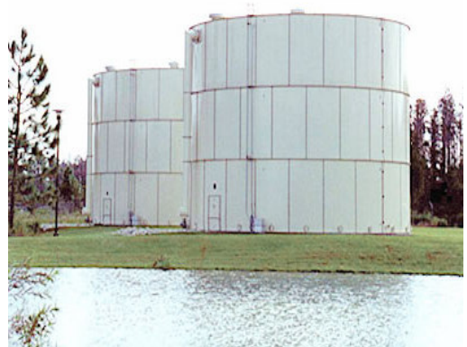
Figura 1.6 Estanque vertical de acero (Fuente: http://www.textoscientificos.com )
