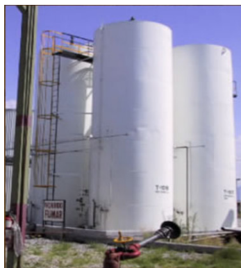
Figura 1.4 Estanque alto y esbelto (Fuente: http://www.otiasa.com )
